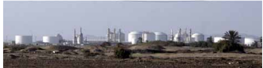
Planta de fraccionamiento, proyecto Camisea en Paracas (J. Reyes)
